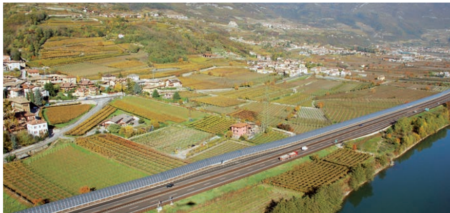
A fianco, la prima barriera antirumore fotovoltaica ad alta efficienza d'Italia. È stata realizzata nel 2009 da Autostrada del Brennero, in collaborazione con il Comune di Isera (Tn)
